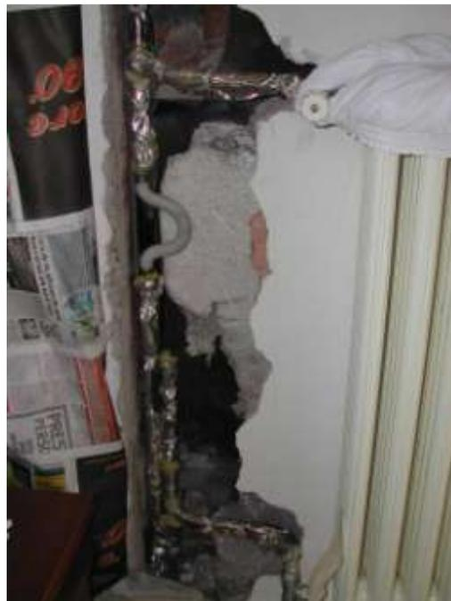
Figura 4 - In una camera da letto le tubazioni di un termosifone "smurate". Notare il materiale isolante per le tubazioni e il giunto flessibile inserito nella mandata.
